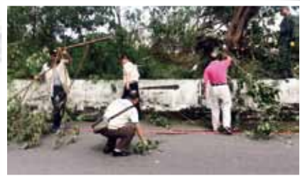
▲桃園市平鎮區輔導中心協助路樹清理作業。
